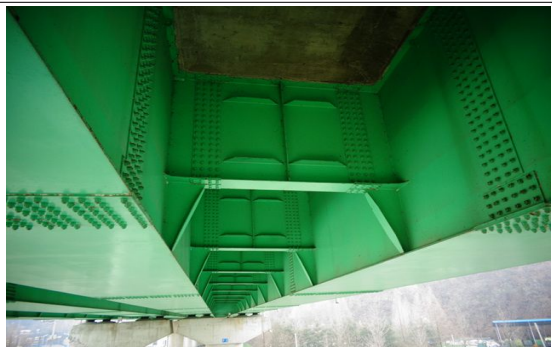
바닥판하면 및 거더 외부 전경
