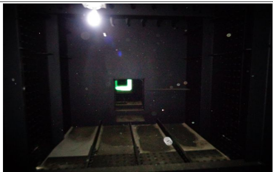
거더 내부 전경
